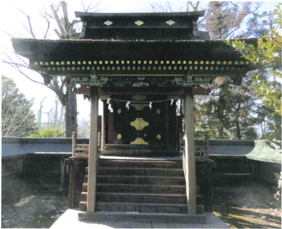
(重要文化財の御本殿の改修工事をします)
